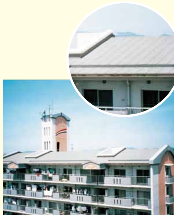
ロンライン施工例
