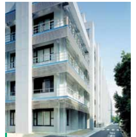
大阪大学基礎工学部本館 ＜大阪府＞
