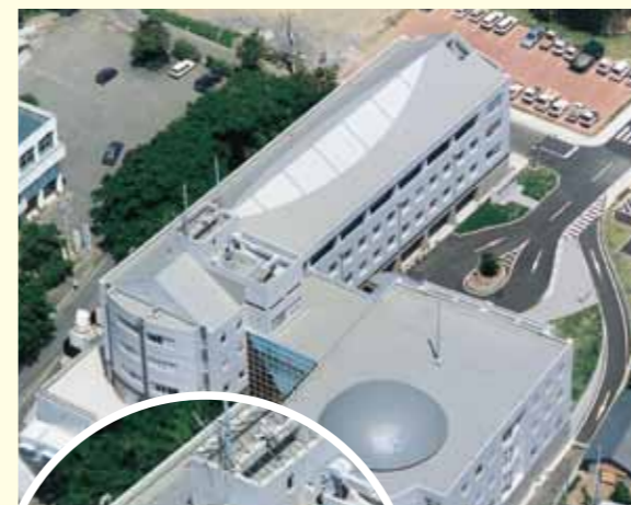
ロンライン施工例
