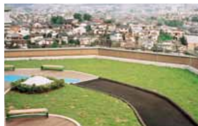
屋上緑化(ロンググリーン仕様)の施工例
