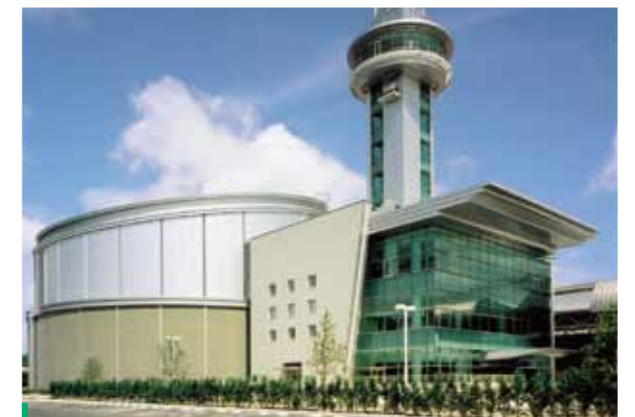
芦屋競艇場施設 ＜福岡県＞
