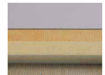
断熱接着工法
