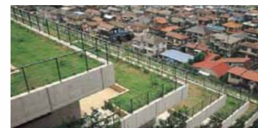
屋上緑化の施工例
