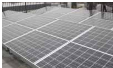
太陽光パネル設置工法の施工例
