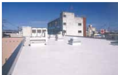
ベストブルーファシャネツ防水仕様の施工例
